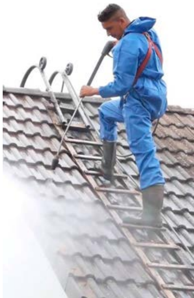
Escada de telhado
